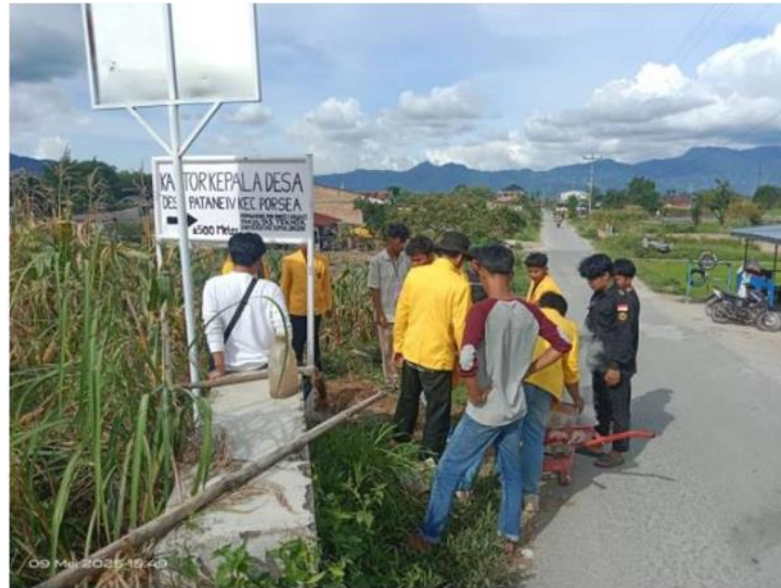
Gambar 4: Pemasangan Papan Petunjuk Jalan Kantor Kepala Desa Patane IV
