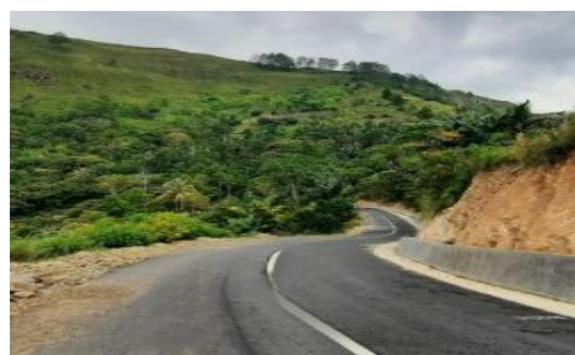
Gambar 2: Kondisi Jalan di Lokasi PPPB
