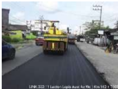
Gambar 4.14 Pemasatan Sekunder dengan PTR
