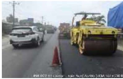
Gambar 4.13 Pemasatan Awal dengan Tandem
