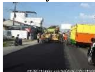
Gambar 4.12 Penghampanan AC-WC menggunakan Finisher
