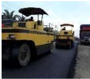
Gambar 4.9 Pemadatan Sekunder dengan PTR
