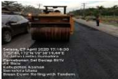
Gambar 4.8 Pemadatan Awal dengan Tandem
