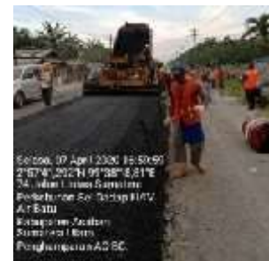
Gambar 4.7 Penghamparan AC-BC menggunakan Finisher
